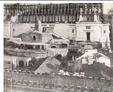
Il Vittoriano in costruzione
